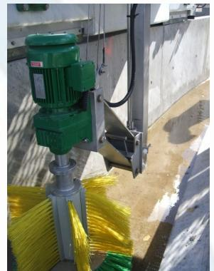
Des options complémentaires incluent : garde-corps en aluminium anodisé, passerelle en caillebotis antidérapant, motorisation avec variateur de vitesse, détection de couple de sécurité, instrumentation de niveau ou de turbidité, brosse de nettoyage.
