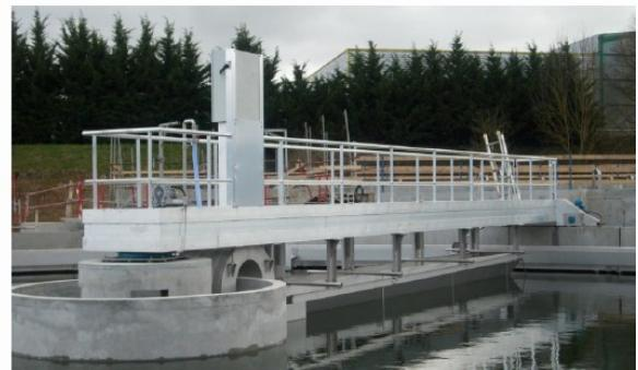
Le pont d'un clarificateur est un équipement essentiel du bassin de décantation d'une station d'épuration. Sa fonction principale est d'assurer la séparation efficace des boues et des eaux clarifiées, en garantissant une extraction continue des matières décantées au fond du bassin et des flottants en surface.
